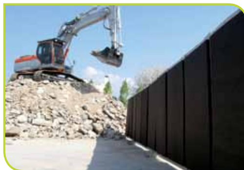
Barriera antirumore per cantiere / scavo
